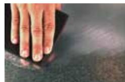
Verzinkte Flächen und Aluminium entfetten Sie mit dem ADLER Entfetter und Scheifvlies. Damit schleifen Sie die Oberfläche gleichzeitig an. So kann der Lack gut haften.
